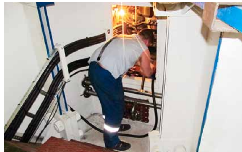
ГЭС-10 Подключение кабелей системы возбуждения гидроагрегата Г-1
