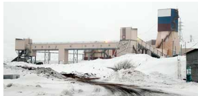
ОАО «Кольская ГМК». Комбинат «Печенганикель» Рудник «Северный-Глубокий» Комплекс сооружений центрального вентиляционного ствола (ЦВС). Монтаж эл.освещения (ЭО) и электротехнических устройств (ЭМ).
