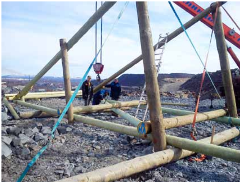
ОАО «Кольская ГМК». Комбинат «Печенганикель» Рудник «Северный-Глубокий» Ведется монтаж опоры ВЛ-35кВ
