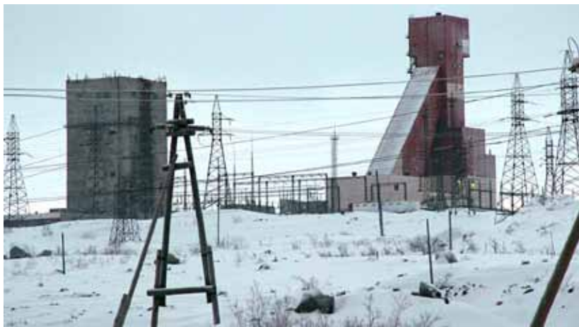
ОАО «Кольская ГМК». Рудник «Северный-Глубокий» Комплекс сооружений ШПУ скипового подъема. Монтаж эл.освещения, электротехнических устройств (ЭС;ЭМ) и средств автоматизации (АСУ ТП)
