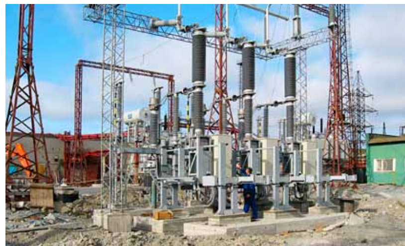
ОАО «Кольская ГМК» ПС-105. Монтаж систем управления приводами высоковольтных выключателей 150кВ
