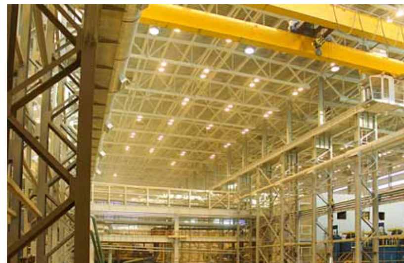
ГОК «Олений ручей» Монтаж основного и аварийного освещения корпуса обогащения
