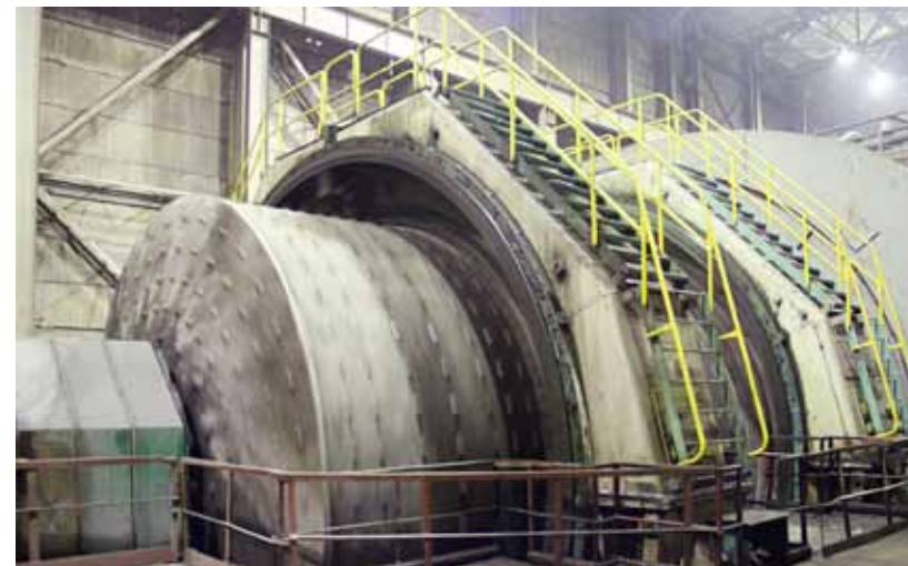
ОАО «Кольская ГМК». Комбинат «Печенганикель» ОФ-1. Шаровая мельница. Монтаж электротехнических устройств (ЭМ) и средств автоматизации (АСУ ТП).
